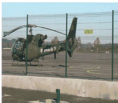
а) Ограждение из сварной сетчатой панели
