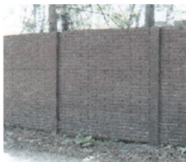
в) Кирпичное ограждение
